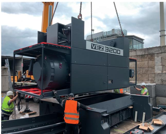
Für die Anlagenerweiterung wurde ein zusätzlicher Einwellen-Vorzerkleinerer der Baureihe VEZ 3200 installiert, der das Material kleiner als 250 Millimeter schreddert. © Vecoplan
